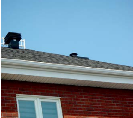
Soffite et fascia
