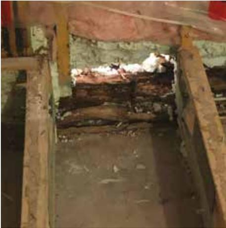
← *Des défauts de conception et de construction, vieillissement prématuré, moisissures, pourrissement du bois et contamination fongique - le résultat d'infiltration d'eau derrière les façades de brique - sont en train de pousser le syndicat de la copropriété à la faillite.*
