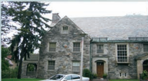
RÉSIDENCE PRIVÉE DU CONSUL DE LA BELGIQUE À MONTRÉAL Réfection professionnelle des joints de mortier, injections des pierres fissurées, impermeabilisation des murs de pierres.
