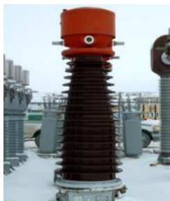
Transformateur de courant
