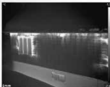
Détection des fuites d'air
